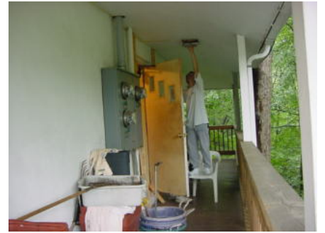
義工拆卸走廊裡的燈以粉刷天花板
