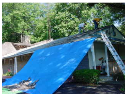
屋頂換修工程
