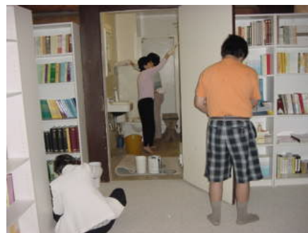
義工們裝修禪修中心樓下的洗手間
