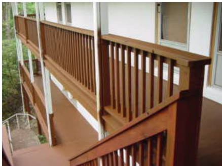
上漆後的通道樓梯
